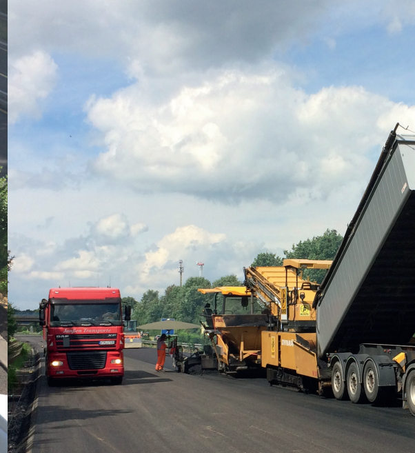
Abb. 2: Im Mai 2016 erfolgte auf der A31 bei Dorsten die grundsätzliche Sanierung beider Richtungsfahrbahnen in Asphaltbauweise auf einer Länge von 6 km zwischen AS Dorsten-Lembeck und AS Regen. Der zweilagige Tragschichteinbau mit einer Gesamtstärke 22 cm wurde in halbseitiger Bauweise ausgeführt. Der Einbau der Binderschicht erfolgte einlagig mit einer Gesamtstärke von 9 cm in halbseitiger Bauweise. Als Deckschicht wurden sowohl 10.000 Tonnen Gussasphalt MA 8S und 1.300 Tonnen PMA 5 eingebaut. Mit BPO wurde sowohl der Materialtransport zur Baustelle als auch der Abtransport des Fräsguts organisiert, um eine möglichst hohe Auslastung des Frachtraums zu erzielen.
