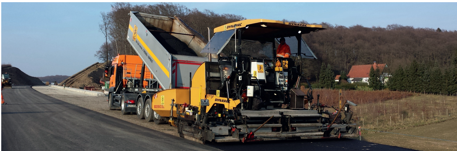
Abb. 1: Im März 2016 wurden an der A33/B51 bei der Ortsumfahrung Belm auf der Hauptstrecke A33, Richtungsfahrbahn Diepholz auf einer Länge von ca. 1,3 km ca. 7.000 Tonnen Tragschicht, 2.500 Tonnen Binder- und ca. 1.500 Tonnen Deckschicht eingebaut. Der Einbau der Binder- und Deckschicht erfolgte mit zwei Fertigern gestaffelt heiß an heiß.
