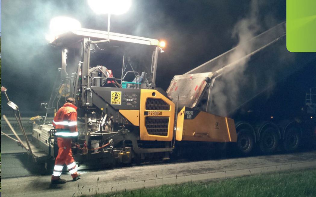
Abb. 3: Im Mai 2016 wurde an der A30 bei Rheine mit einer Nachtbaustelle gearbeitet. In 12 Nächten wurde jeweils ab 20:00 Uhr die Verkehrssicherung aufgebaut und bis 22:00 Uhr die Fahrbahndecke abgefräst. Zwischen 22:00 Uhr und 01.00 Uhr wurden AC 22 BS und SMA 8 S eingebaut. Gegen 4:00 Uhr wurde die Fahrbahnmarkierung aufgebracht und um 6:00 Uhr erfolgte die Freigabe für den Verkehr.
