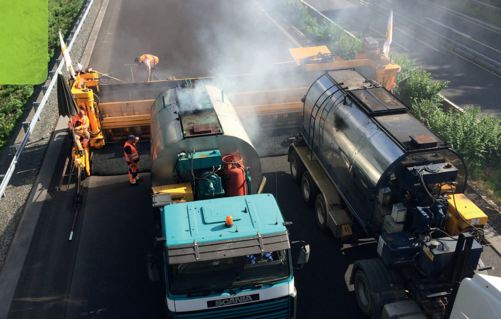
Abb. 2: Im Mai 2016 erfolgte auf der A31 bei Dorsten die grundsätzliche Sanierung beider Richtungsfahrbahnen in Asphaltbauweise auf einer Länge von 6 km zwischen AS Dorsten-Lembeck und AS Regen. Der zweilagige Tragschichteinbau mit einer Gesamtstärke 22 cm wurde in halbseitiger Bauweise ausgeführt. Der Einbau der Binderschicht erfolgte einlagig mit einer Gesamtstärke von 9 cm in halbseitiger Bauweise. Als Deckschicht wurden sowohl 10.000 Tonnen Gussasphalt MA 8S und 1.300 Tonnen PMA 5 eingebaut. Mit BPO wurde sowohl der Materialtransport zur Baustelle als auch der Abtransport des Fräsguts organisiert, um eine möglichst hohe Auslastung des Frachtraums zu erzielen.
