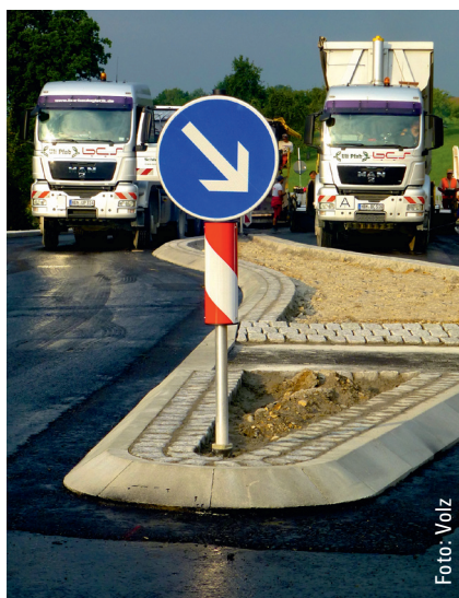
Prozessoptimierung, Temperaturerfassung und Dokumentation spielen beim Asphaltbau eine immer wichtigere Rolle.
