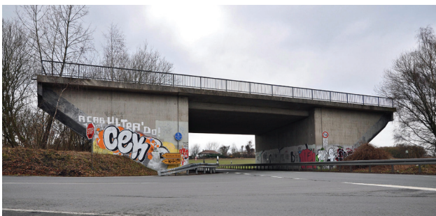
Beispiel im Buch: „Nur-so-da-Brücke“ in Schwerin, einem Stadtteil von Castrop-Rauxel, fertig gestellt 1980. Die geplante Straße wird wohl nicht mehr gebaut. (Foto: Ruhr Nachrichten)
